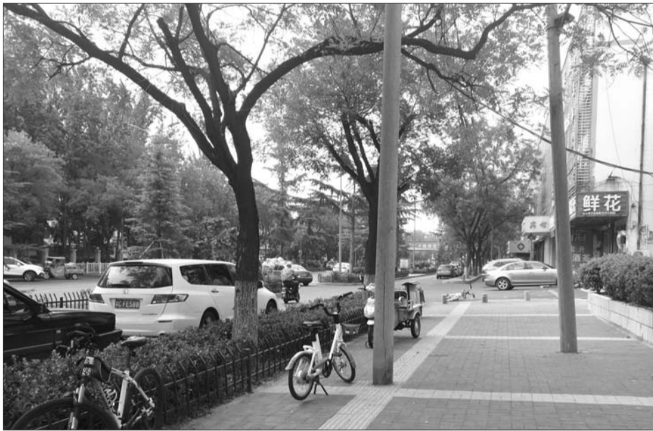
电线杆压盲道。
