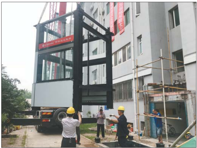
济南市一老楼加装电梯现场,工作人员正在吊装电梯。本报记者 王杰 摄
