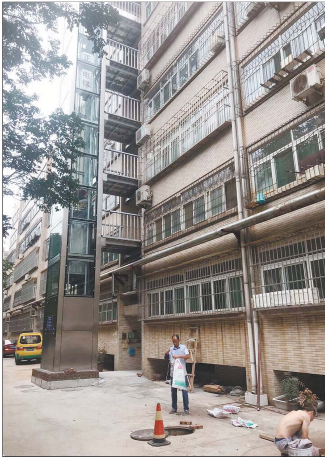
甸柳新村内一单元楼刚加装的新电梯。本报记者 王杰 摄
