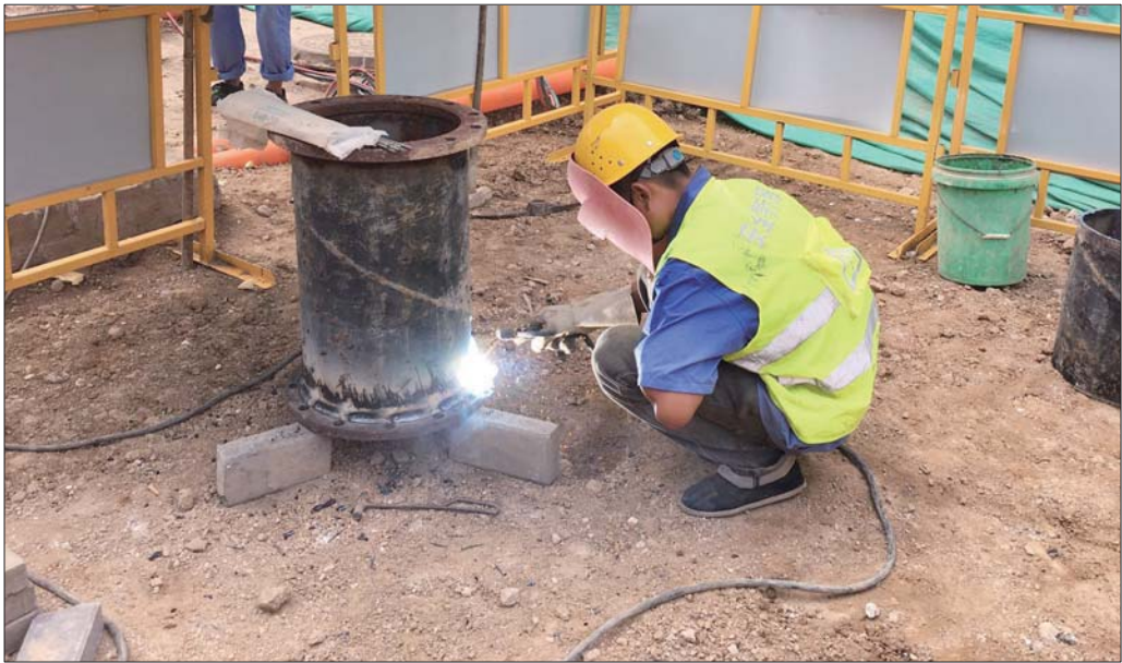
济南水务工作人员正在焊接预制管件。
