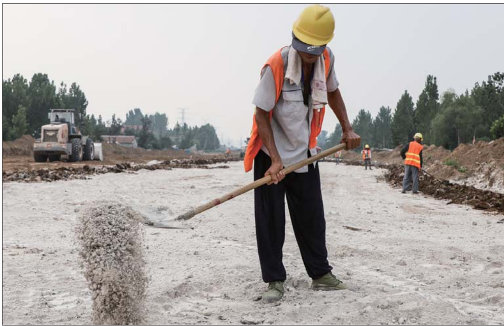
正在施工中的古槐路北延项目现场。 本报记者 李岩松 摄
