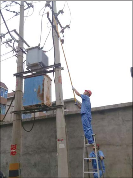
电气班组对厂内、厂外所有电气设备及变压器进行检修。
