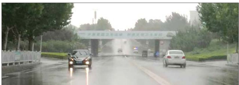
北天门大街立交桥洞下无积水影响交通。
