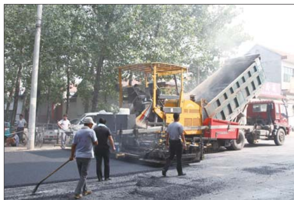
镇街五条主要道路及部分短街铺设沥青中。
