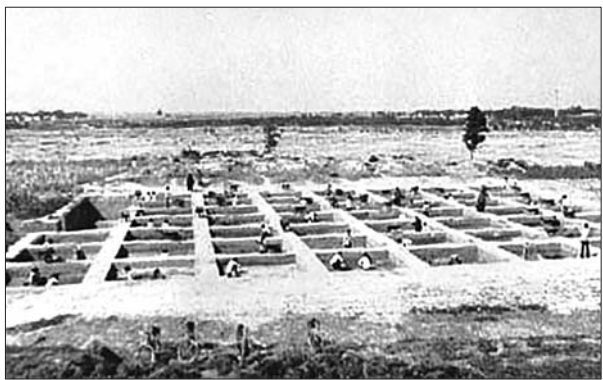
山东后李春秋车马坑挖掘现场
