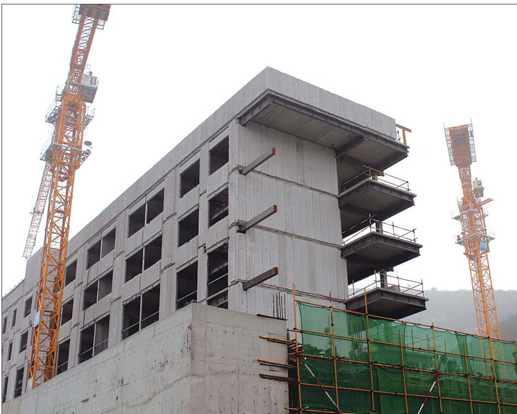
济南首所国际学校施工现场。
