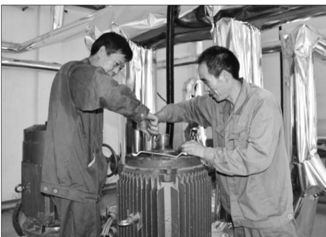
检修人员正在检修和保养机组。 本报记者 孙璇 摄
