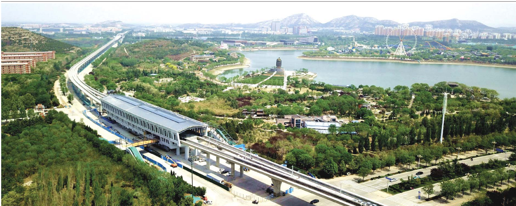
建设中的济南轨道交通R1线园博园站。 济南轨道交通集团供图
