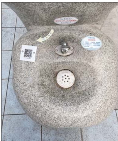
一些取水点已经安装了不锈钢激光打印的二维码。
