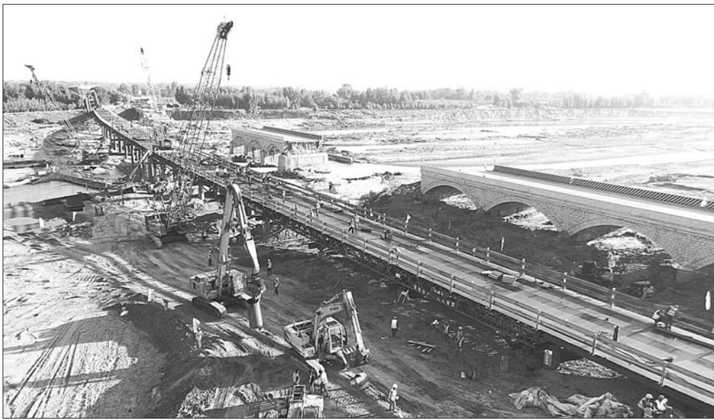
建设中的昌乐汶河平原大桥钢栈桥,一侧是被洪水冲毁的原桥梁。
