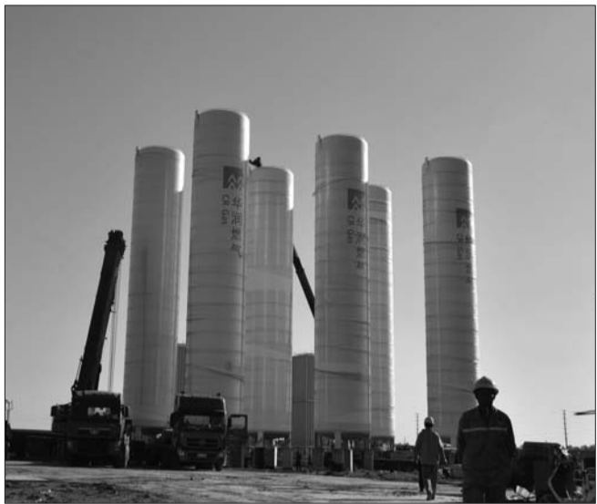
施工方天然气储气罐。本报记者 孙璇 摄
