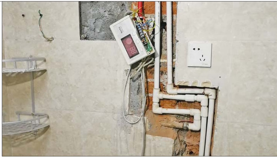
尚未完工的卫生间。
