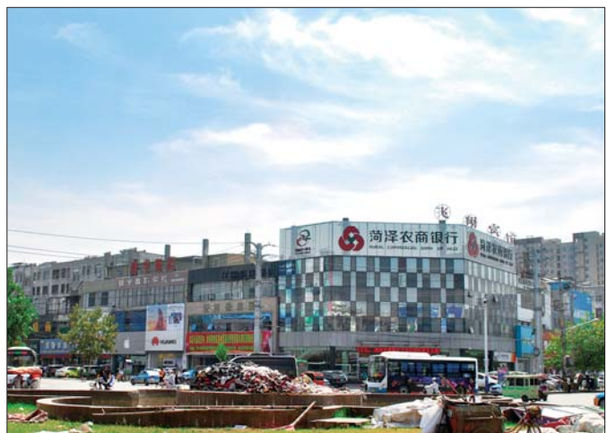
中心广告塔被拆除后的三角花园。
