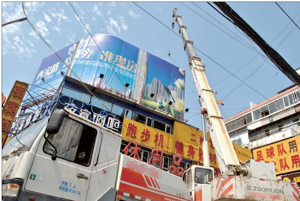
三角花园西北角一楼顶广告正被拆除。
