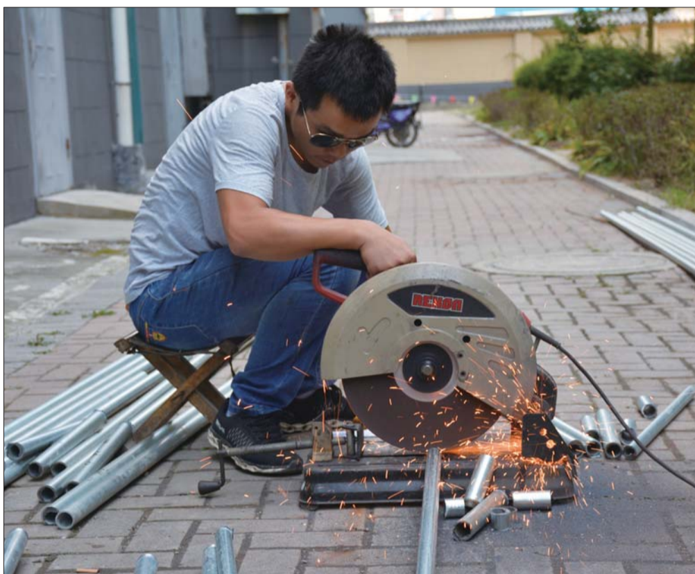
在金色佳苑小区内,施工人员正在切割楼道管。 本报记者 孙璇 摄
