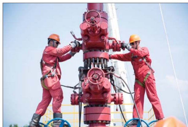
胜利石油工程公司涪陵页岩气项目带压作业施工。
