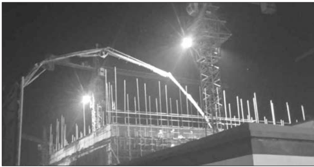
工地夜间施工。
