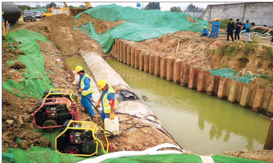
机械破除后的原水管线正在放水,现场有十台水泵抽水,工人们正在为电机加油。本报记者 王皇 摄
