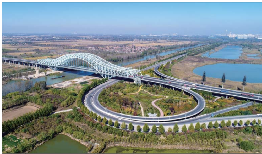
南二环(临菏路)京杭运河大桥。
