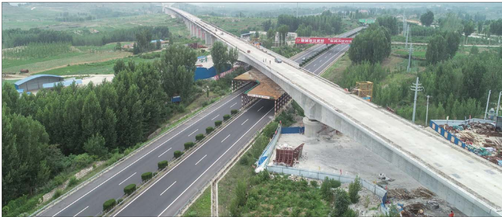
鲁南高铁跨日东高速特大桥。
