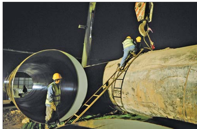
26日0时20分,5号合口旧的管道被拆除,准备安放新的管道。
