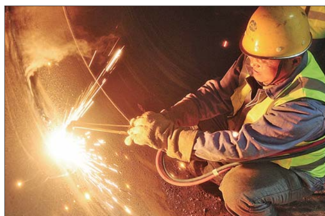
26日0点40分,5号合口工人进入管道内切割拆除旧管道。
