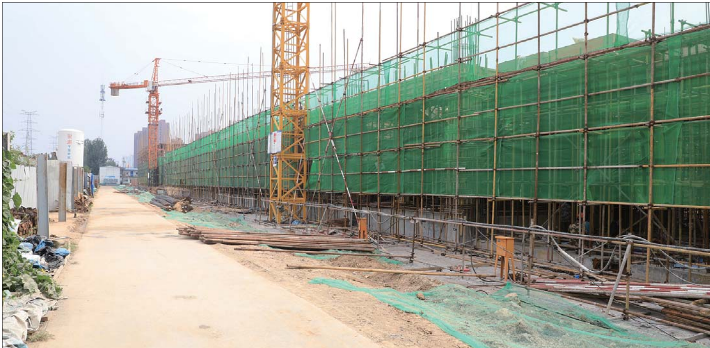
热火朝天的施工现场。 本报记者 黄健恒 摄
