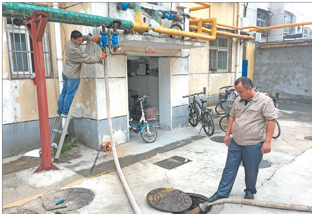
片区人员正在为小区供热管网“冲管”。 本报记者 张帅 摄
