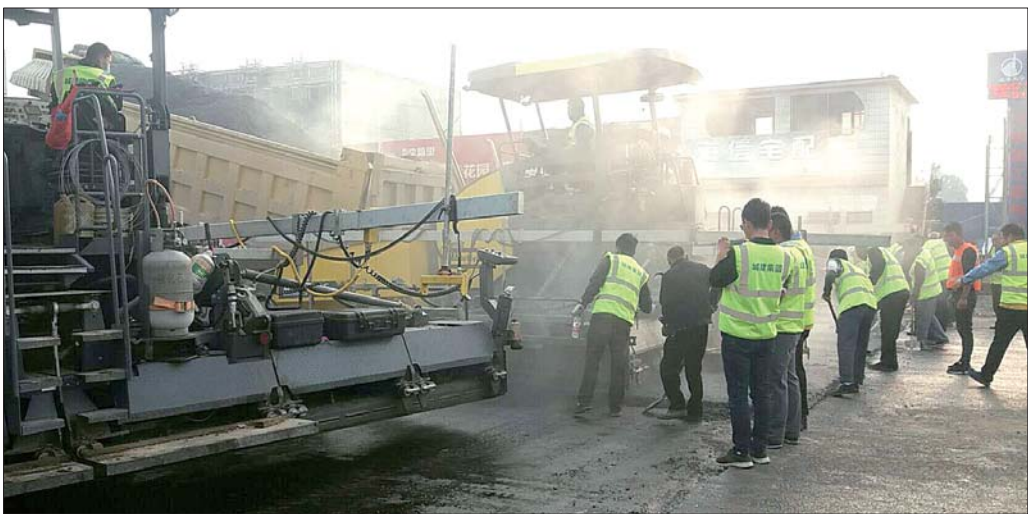
施工人员进行面层施工。
