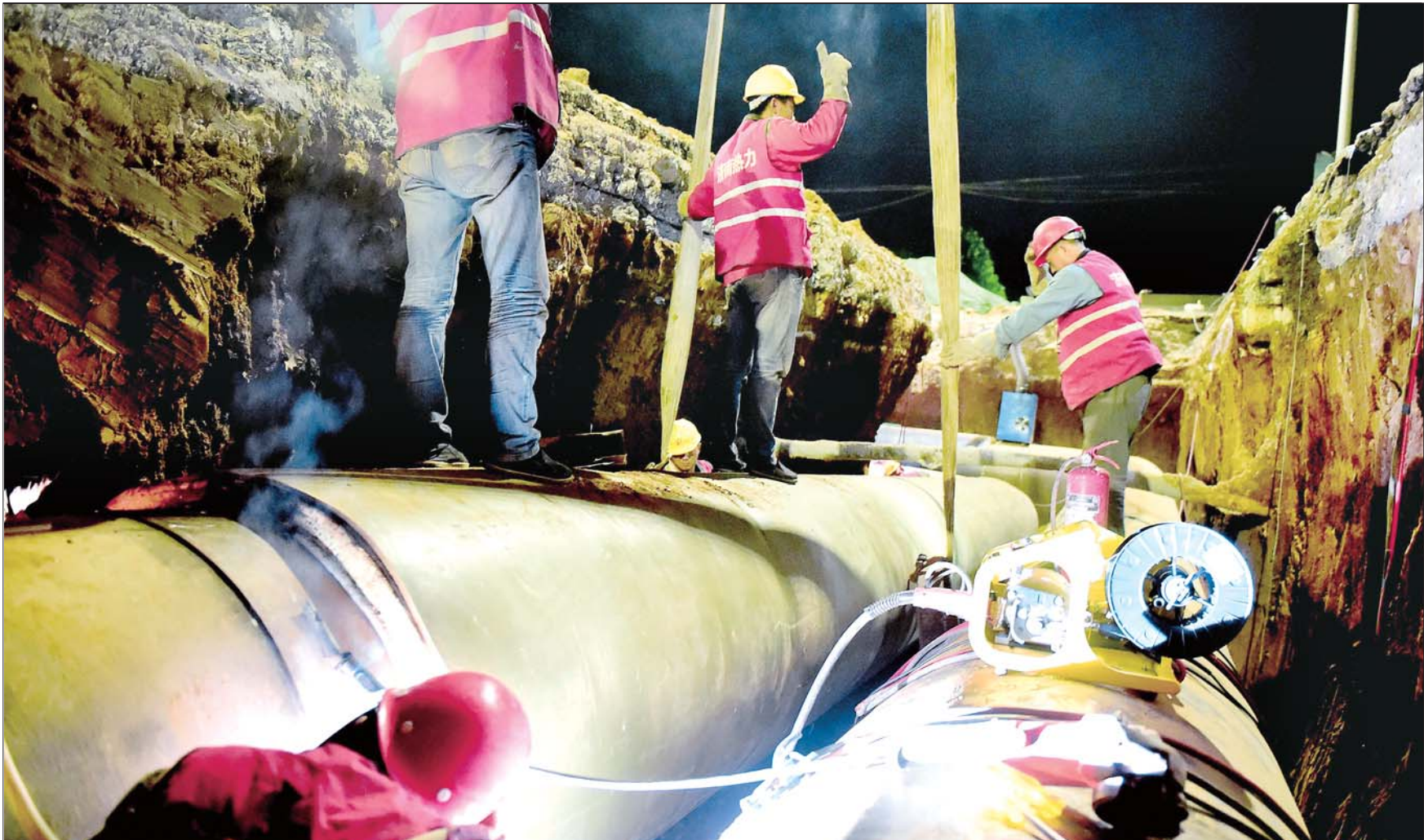
7日晚,在春晖路热力管网工程现场,济南热力工作人员在土坑内焊接管道。本报记者 邱志强 摄
