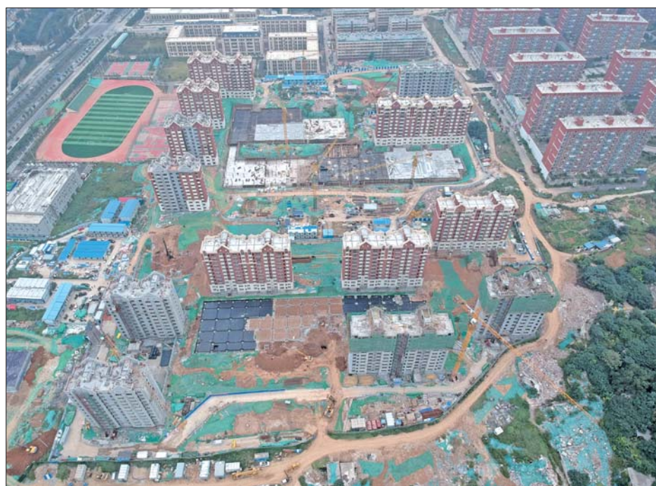
中海国际社区最后的两个地块正在加紧施工,片区内的拆迁将清零。
