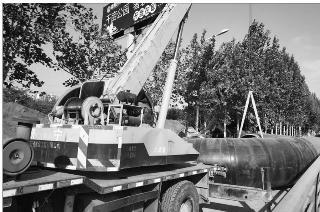
诗仙路施工现场正在吊装管道。 本报记者 孙璇 摄
