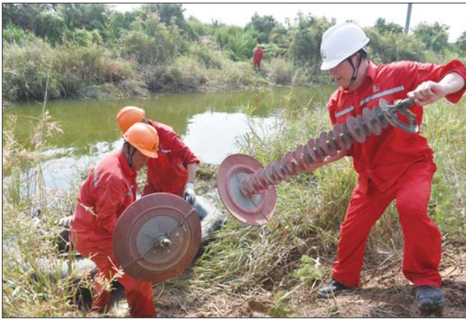
员工为110千伏新渤线更换绝缘子。
