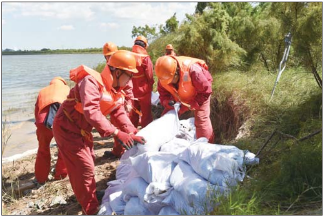
东区供电公司加固110千伏九广线拉线基础。
