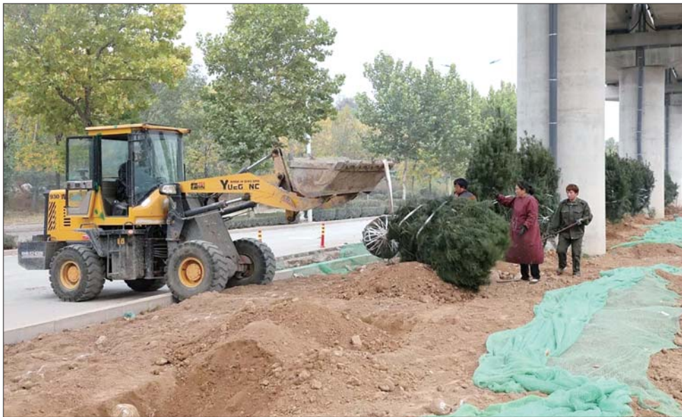
长清大学城海棠路道路修复和绿化工程近日全面启动。
