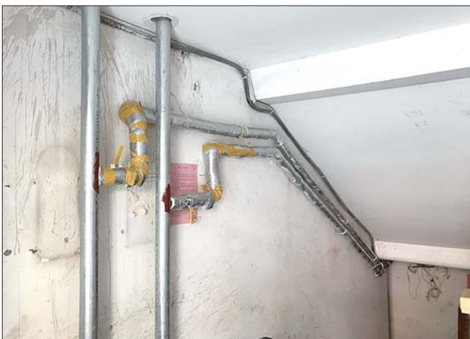
东元山庄楼道内室外供暖管道改造完成。本报记者 王杰 摄
