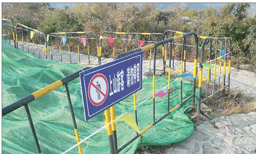
东山山顶消防工程工地设立了隔离带。
