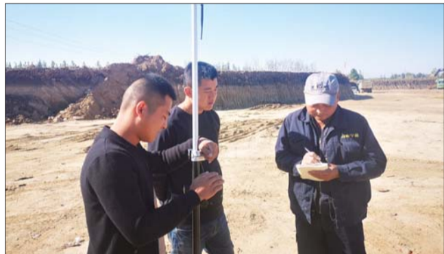
工作人员正在进行实地测量。
