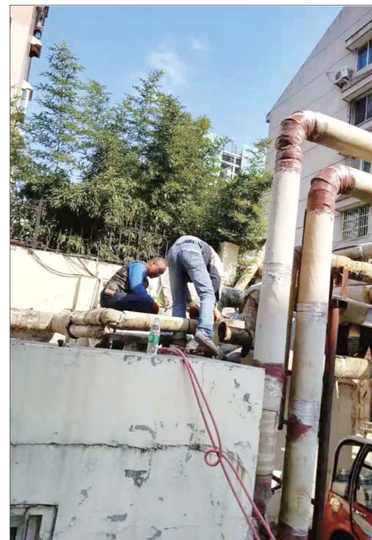
中环小区物业免费检修小区老管道。不过在供暖改造上,多数物业都不愿过度介入。 本报记者 王杰 摄
