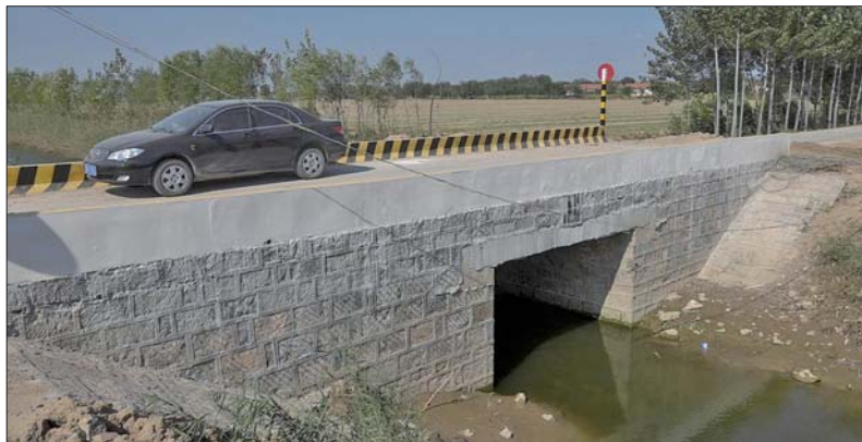
新修的生产桥。
