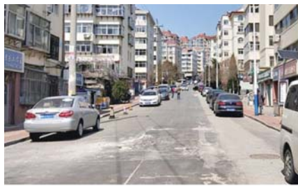
苏州街改造前面貌
