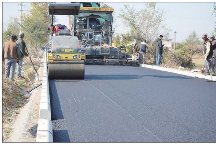
11月5日,县道407麦泽线沥青混凝土路面施工现场。
