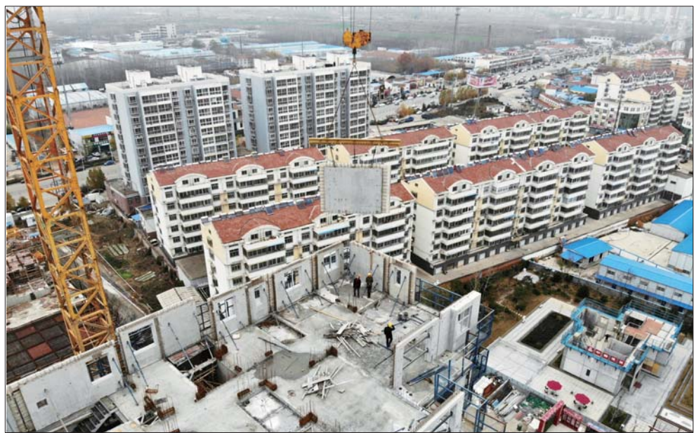
装配式建筑施工现场,就像垒“积木”。 本报见习记者 王飞 摄
