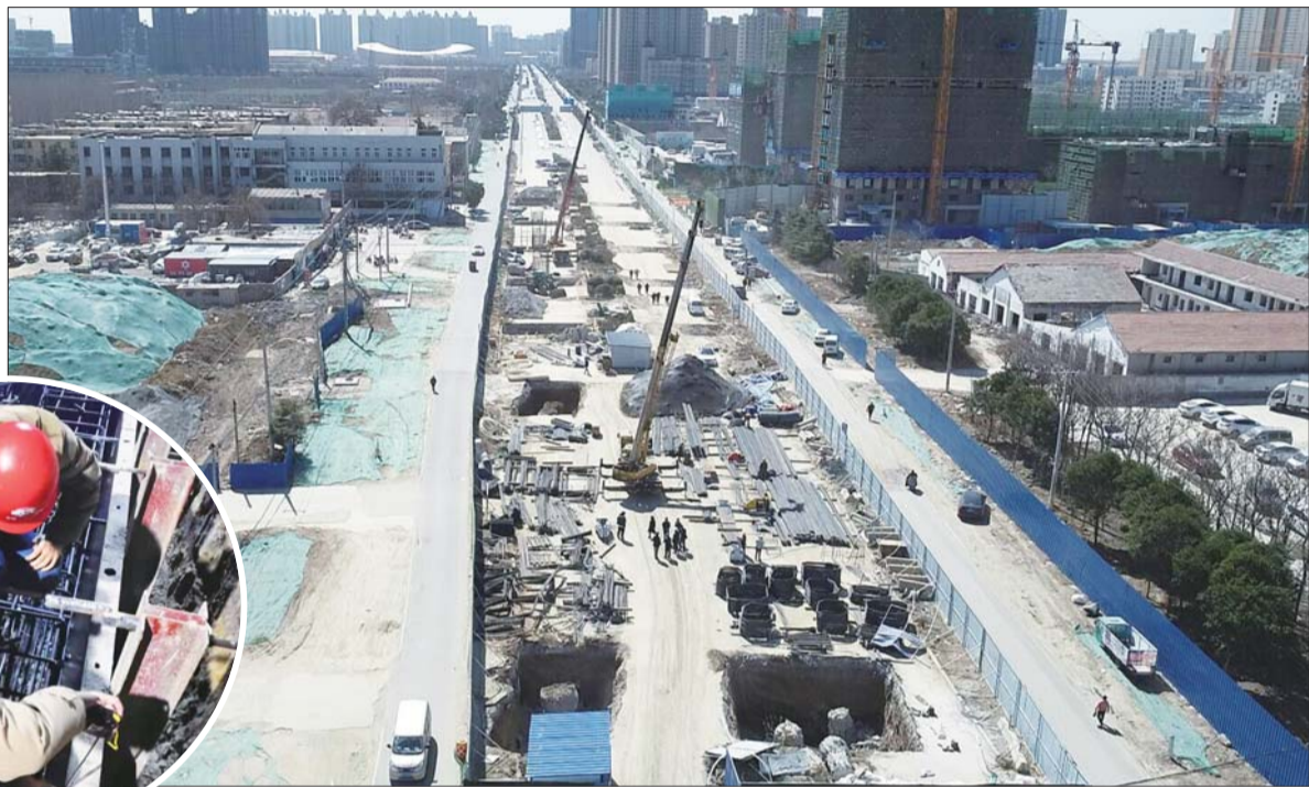
跨线桥施工现场,两侧留出了便道。本报见习记者 梁响 摄
