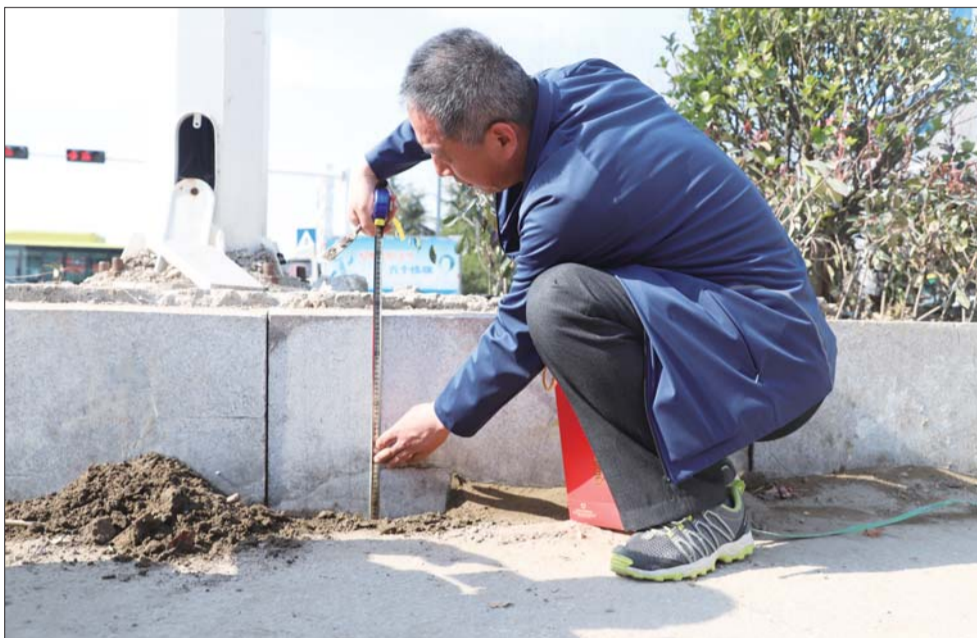
工作人员现场测量B类路沿石高度。本报记者 孔茜 摄
