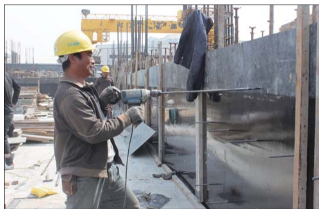
工人正在紧张作业中。
