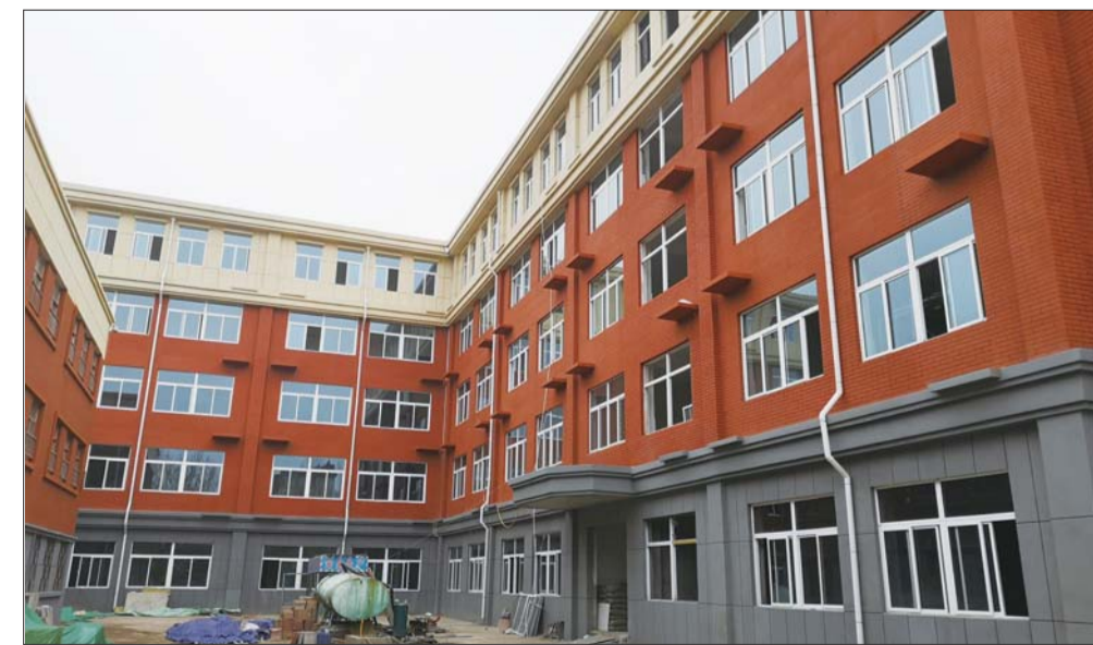
综合教学楼已基本完工。
