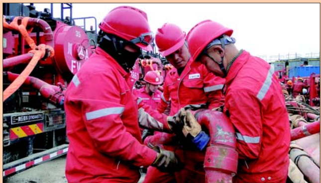
员工在压裂现场做管线连接准备工作。
