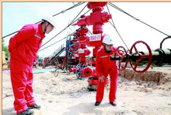
机关部门到现场指导帮扶压裂工作。
