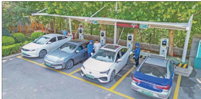
国网济南市历城区供电公司彩虹党员服务队到九如山风景区停车场，对充电桩进行安全用电检查，助力旅游绿色出行。冯立文 摄
