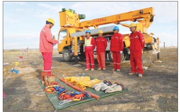
检修开工前,施工单位都会进行安全交底,确保安全生产,快速检修。
