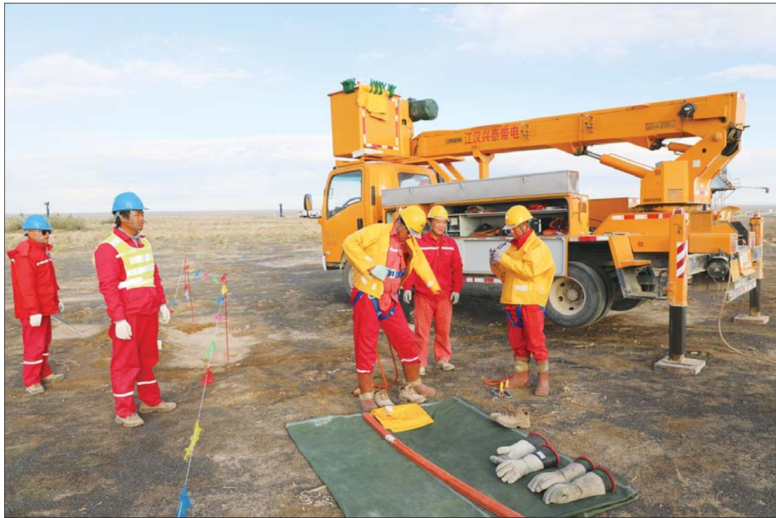
正式检修前,检修人员需要提前穿上十几斤重的绝缘服、带着厚厚绝缘手套,才能开始施工。
