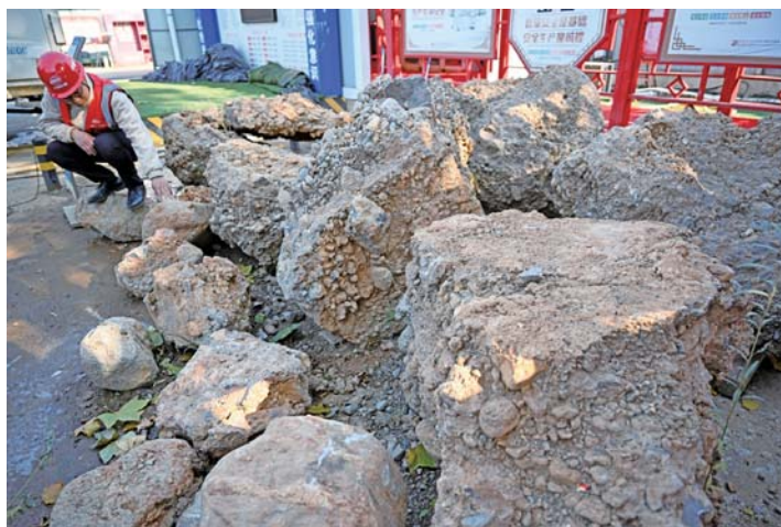
济南地铁4号线4工区施工段挖出来的部分胶结砾岩。
