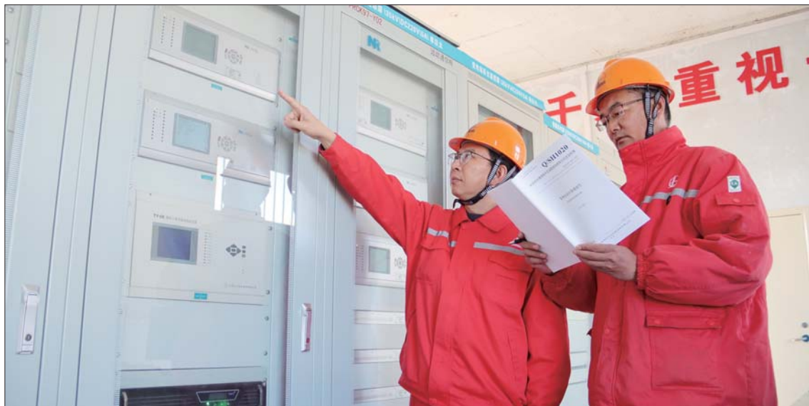
职工参照新修订的标准手册对测控柜电压、电流数据进行检查。 通讯员 蔡明战 摄
