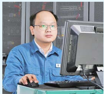
魏卓在信息机房检查系统运行状态。 通讯员 何延海 摄
