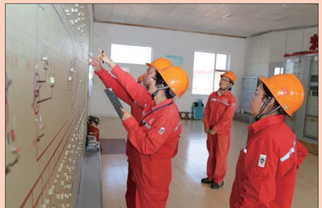
送电前，变电站值班员在模拟盘进行模拟操作。通讯员 赵雅洁 摄
