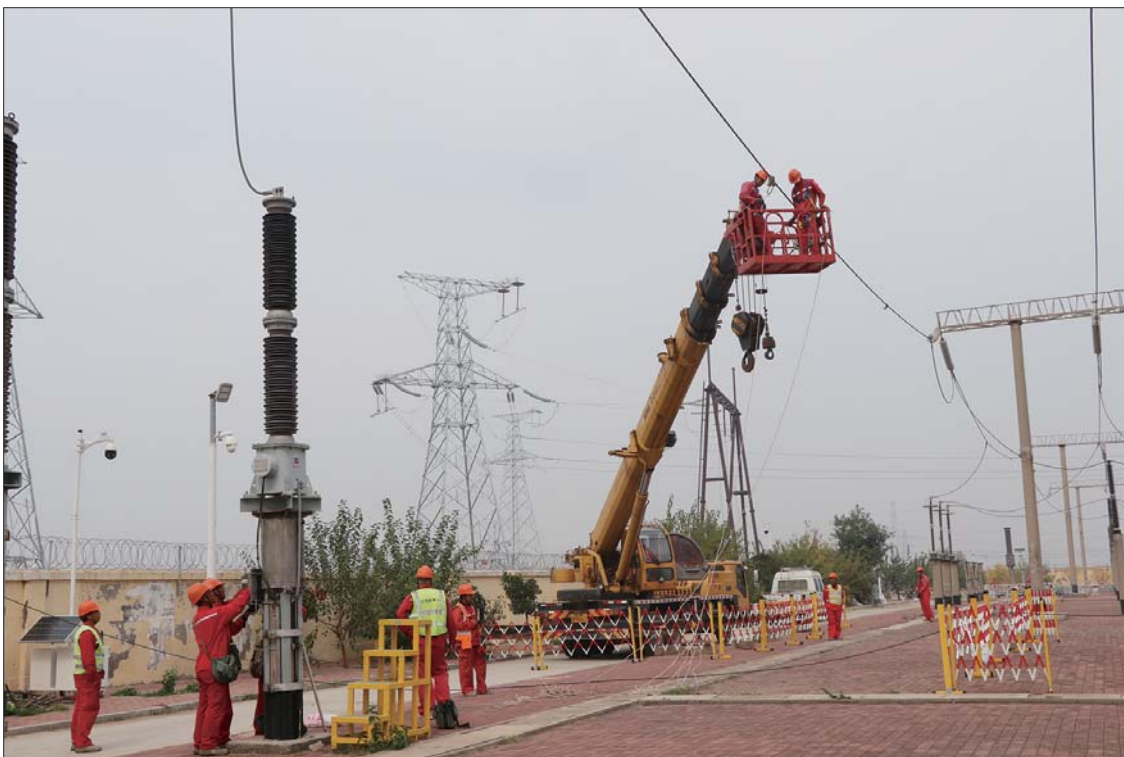
九孤线停电改造施工现场。
