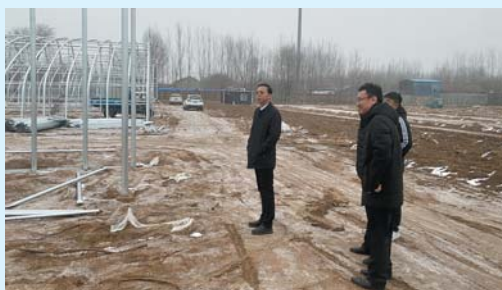
区农发集团董事长、总经理李庶东到仁风镇乡村振兴项目工地察看项目进展情况。
