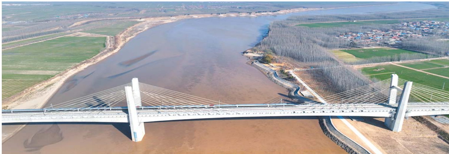
2023年12月8日,列车驶过济郑高铁长清黄河铁路特大桥。当日,济郑高铁全线贯通运营。新华社发
